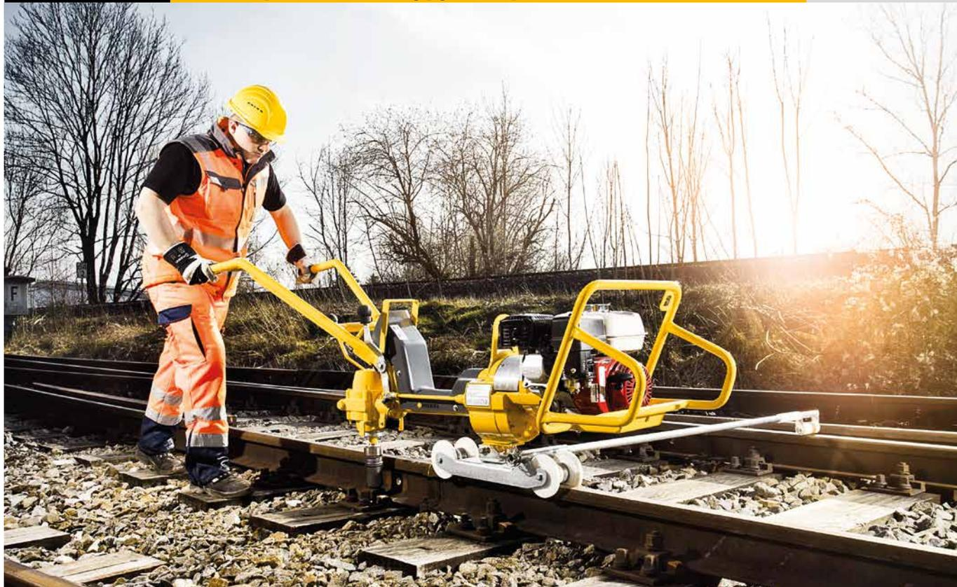
Для затягивания или отвинчивания рельсовых шурупов, крюковых и соединительных болтов
