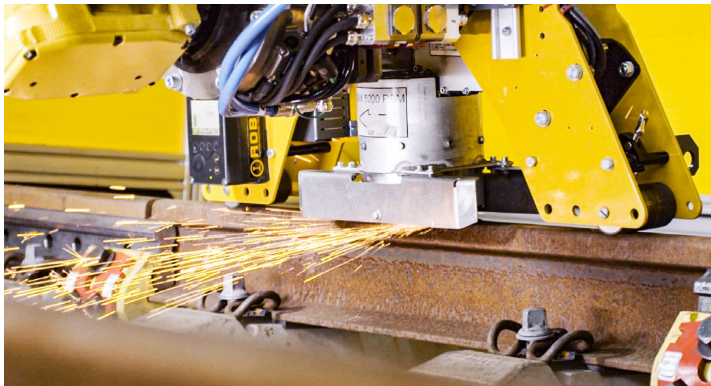
Abb. 6: Feinschliff der bereits im Fräsprozess erzeugten Facetten der Schienenoberfläche
