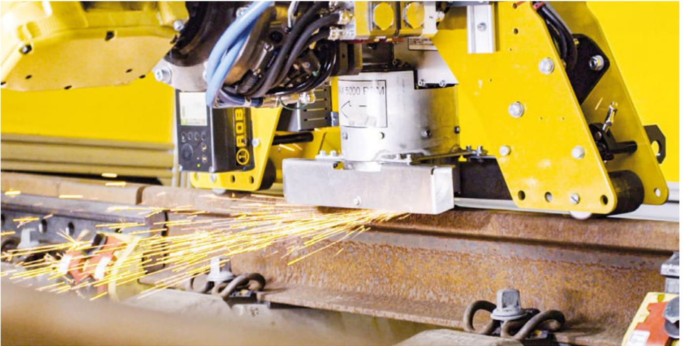
**Abb. 6:** Feinschliff der bereits im Fräsprozess erzeugten Facetten der Schienenoberfläche
